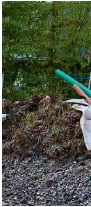
Speziell angefertigte Filterboxen für den Umbau der Biobadi Biberstein
