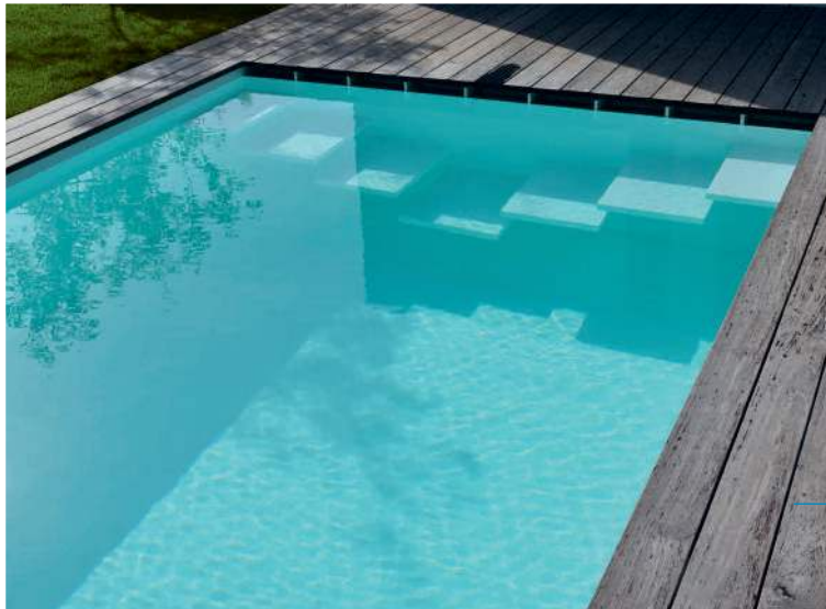
PP-Kompaktbecken mit schwebender Treppe
